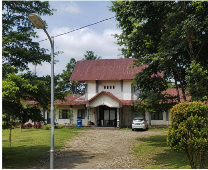
Gambar 1. Kondisi eksisting Balai RW di Desa Pongangan
