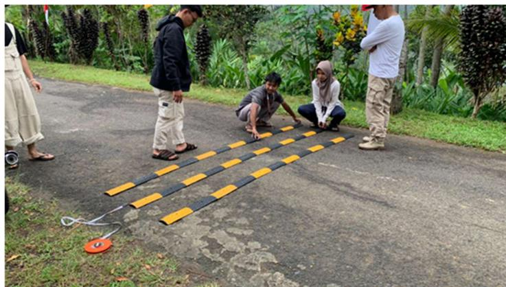
**Gambar 4** Hasil Pemasangan speed bump
