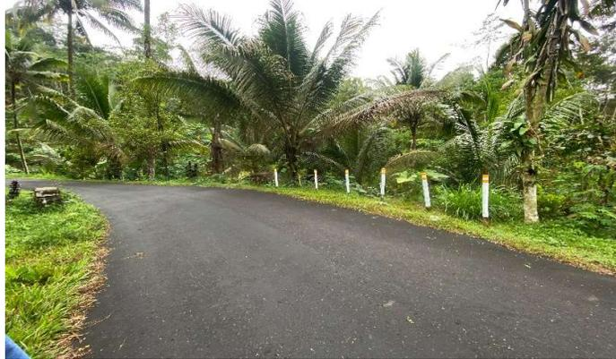
**Gambar 3** hasil pemasangan reflektor
