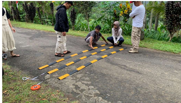
Gambar 4 Hasil Pemasangan speed bump
