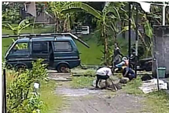
Gambar 3 Proses Pemasangan Portal oleh Tenaga Profesional
