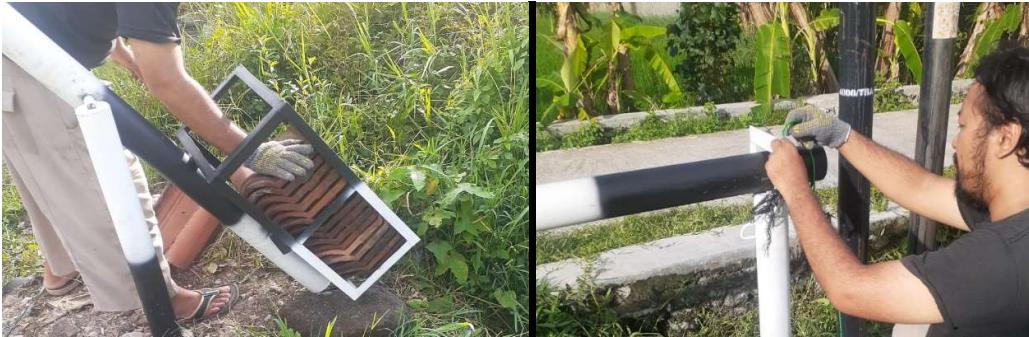
Gambar 4 Proses Pemasangan Komponen Pemberat dan Tali Penggunci
