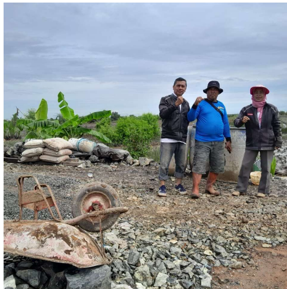
Gambar 3 Pembangunan Septic Tank dan WC Gratis
