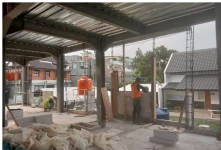
Pasang Dinding Hebel
