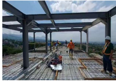
Persiapan Pengecoran
