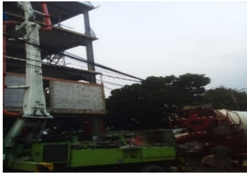
PENGECORAN DENGAN CP
