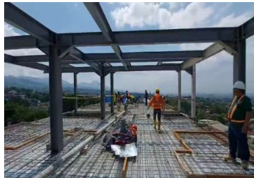
PERSIAPAN PENGECORAN
