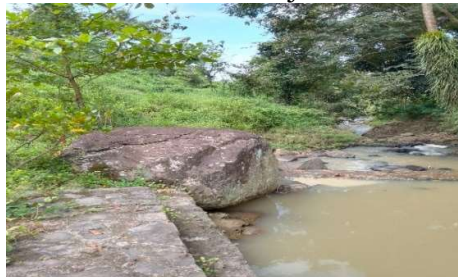
Gambar 3. Titik akhir jalan beton
