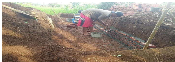
Gambar 4. Pembuatan Biodigester
